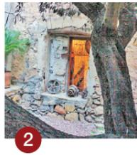
**Ladronera:** Depósito que recibe directamente los residuos de los cocioles. Según el sistema de sifón por sedimentación se depura el aceite que queda. Se comunica la ladronera del interior de la almazara con las ladroneras del exterior por donde salían los residuos hacia la reguera de "detrás de las casas" que lleva a la Acequia del Molino.
